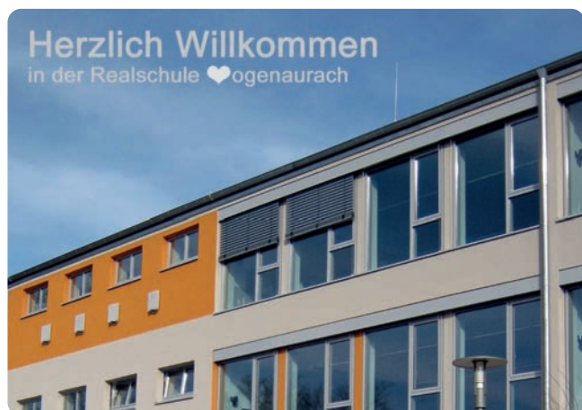
Haupteingang: Ansicht des sanierten Gebäudes (RSH)
