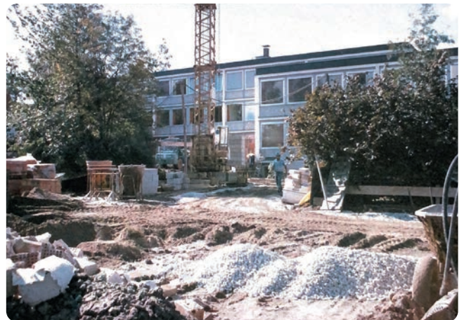
Bauarbeiten zur Anbindung der ehemaligen Kreisberufsschule an das Realschulgebäude 1987 (Stadtarchiv)
