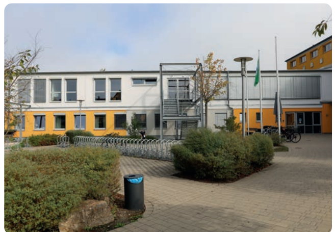
Aufstockung des Verwaltungstrakts (RSH)
