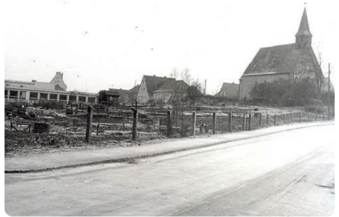
Baugelände für die Realschule vor Baubeginn mit Schrebergärten (privat)
