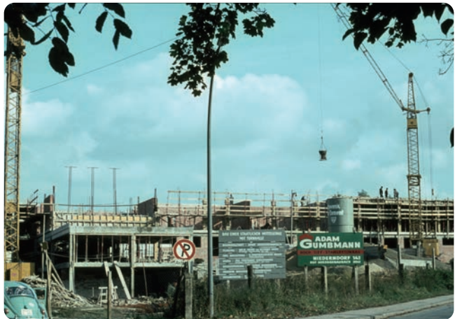
Baustelle Realschule 1963 (Stadtarchiv)
