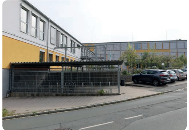
Neue Fassade (RSH)
